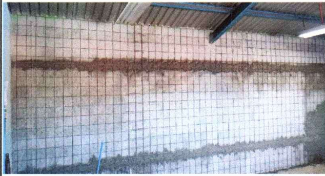
Foto 1: Fundicion y repello de muros en aula 1
