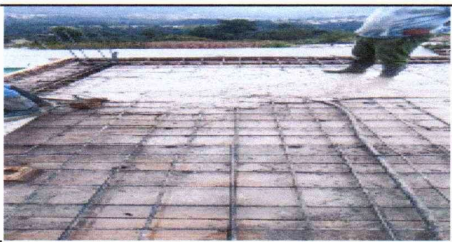
Foto 5: Sustitucion de techo de lámina por losa de concreto
