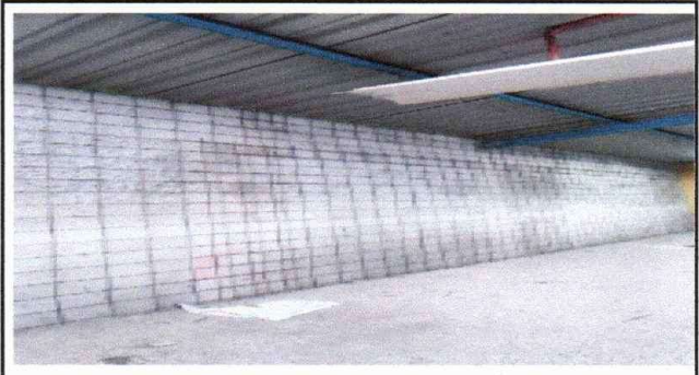
Foto 2: Fundicion y repello de muros en aula 2
