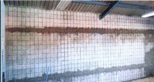
Foto 4: Fundicion y repello de muros en aula 4
